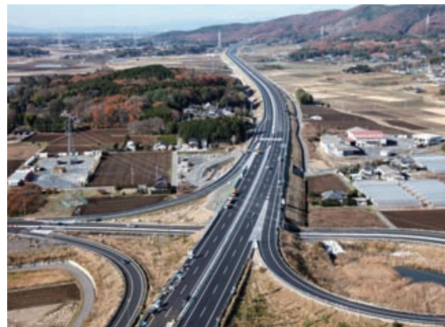
北関東自動車道 桜川西舗装工事
