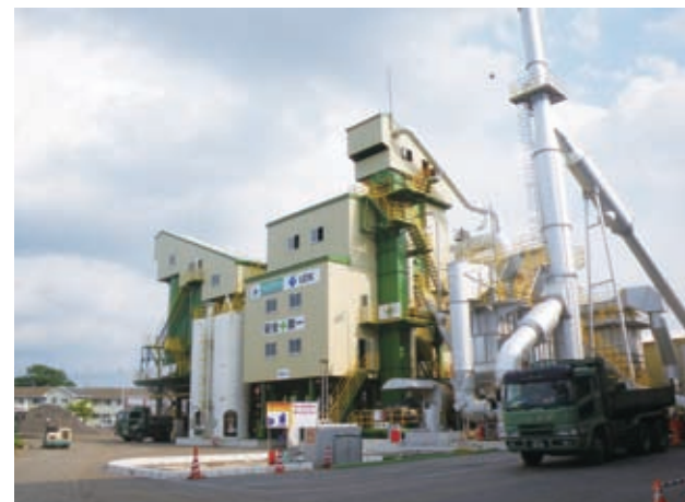
越谷合材工場
