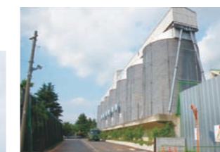
骨材貯蔵を全閉型のコールゲートビンとし、植栽などの環境整備を推進
