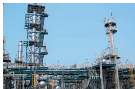
新日本石油(株)新潟事業所 運転訓練装置
