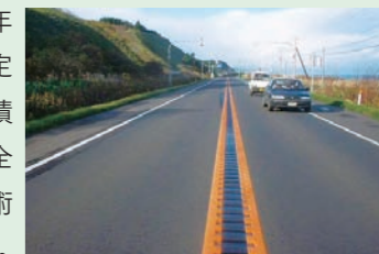
一般国道5号・北海道八雲町での施工例
