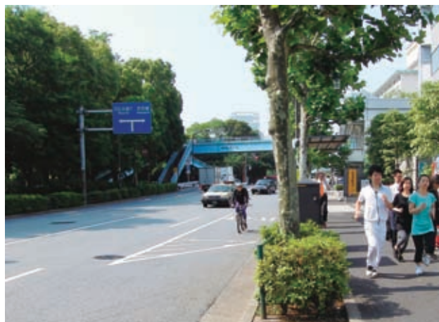
東京都港区 路面補修工事(遮熱性舗装)
