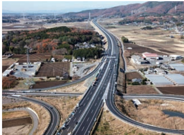
北関東自動車道 桜川西舗装工事
