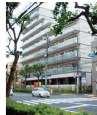
東京都杉並区 堀ノ内プロジェクト新築工事
