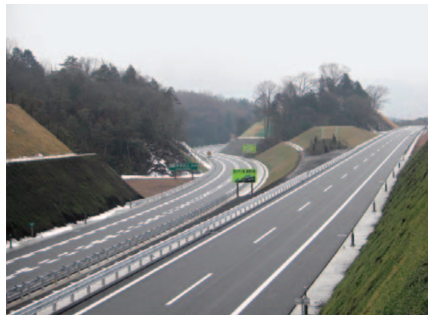
新名神高速道路 大津舗装工事
