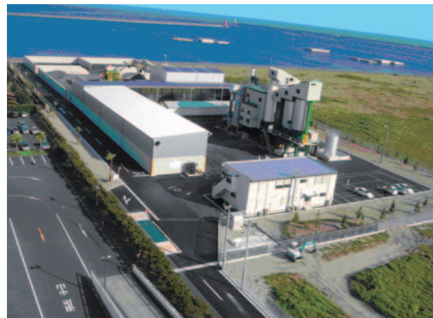
鹿児島合材工場(2007年10月開設)
