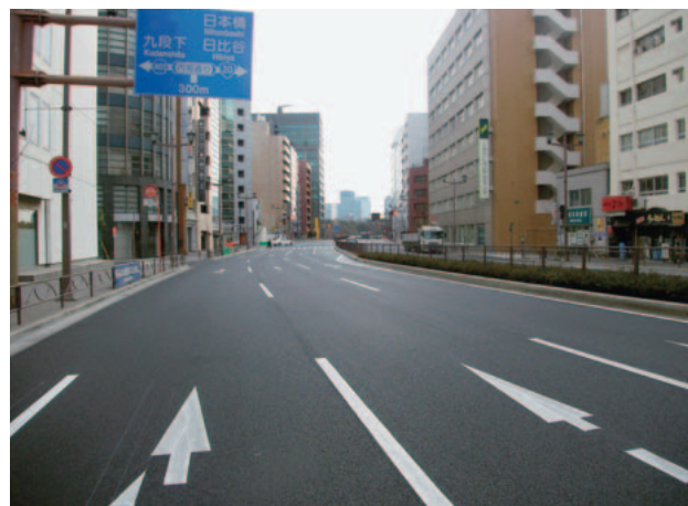
国道20号 麴町舗装修繕工事
