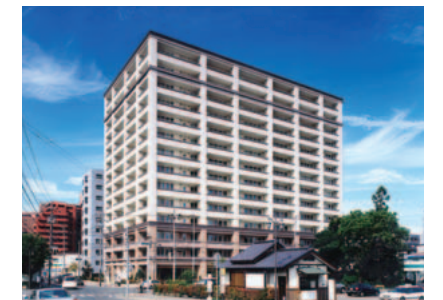
岩手県盛岡市 ル・サンク上の橋
