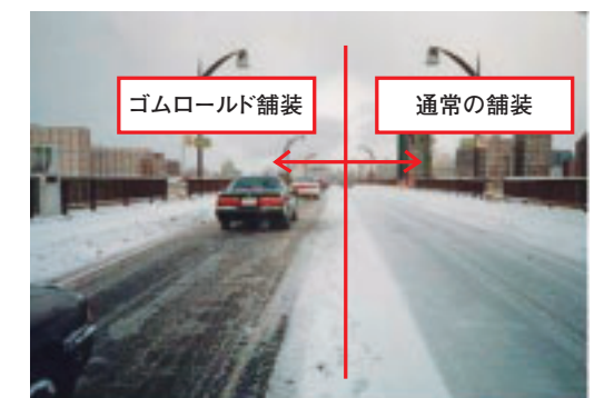
左車線がゴムロールド舗装(新潟県新潟市)
