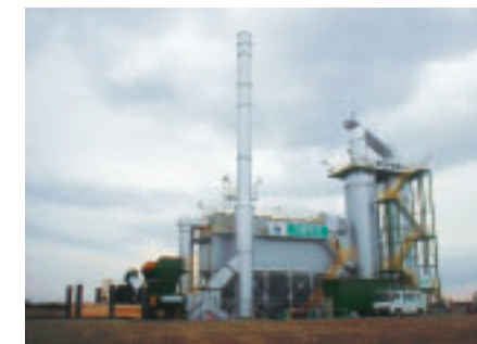
加熱乾燥プラント2号機
