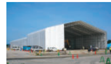
大型テント内での 揮発性有機化合物の処理
