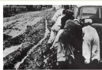
雨でぬかるみ車を押して進む当時の道路
