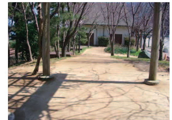
新潟県内の「道の駅」での試験舗装
