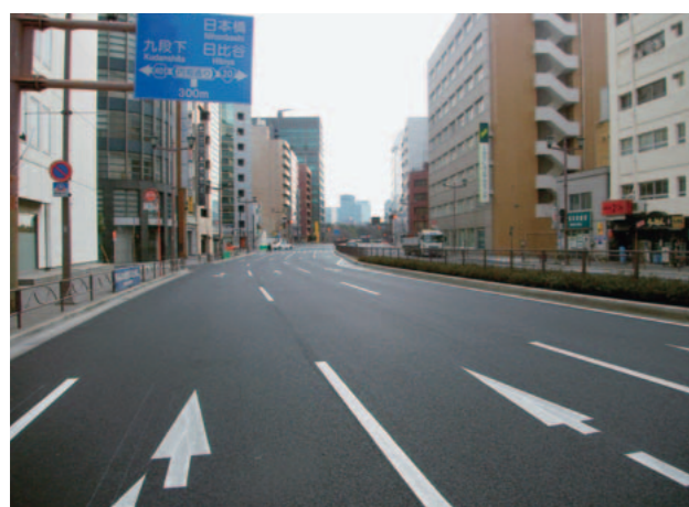
国道20号 麴町舗装修繕工事
