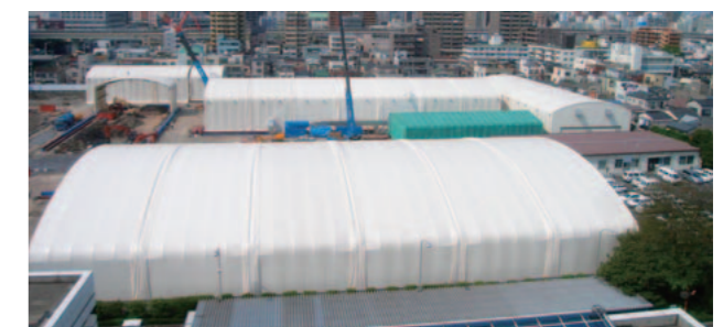
大規模再開発地域における大型テント内での土壌浄化工事
