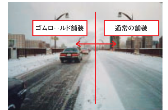
左車線がゴムロード舗装(新潟県新潟市)
