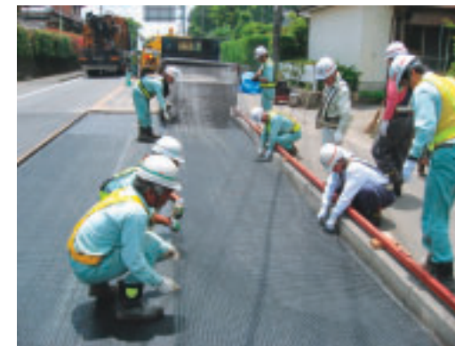
パイロペープの施工状況(宮崎県都城市)
