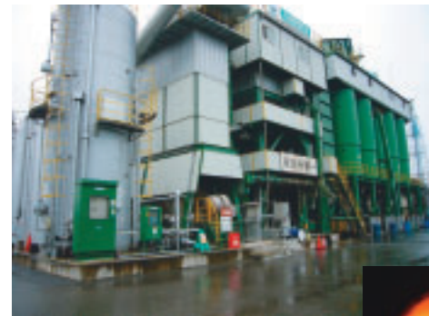
アスファルト合材工場
