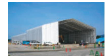
大型テント内での揮発性有機化合物の処理
