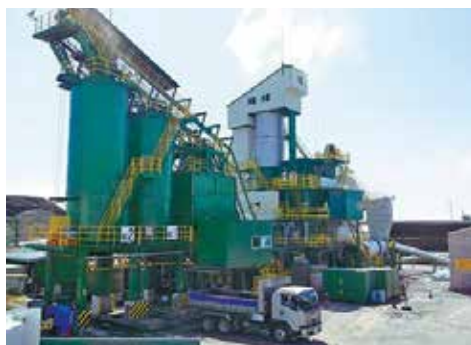
被災した合材工場の完了時全景(前部)
