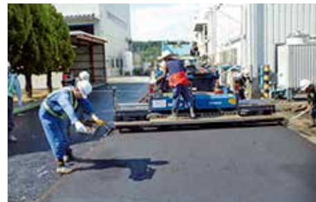
リピットペーパーの施工状況 (報道発表資料から)
