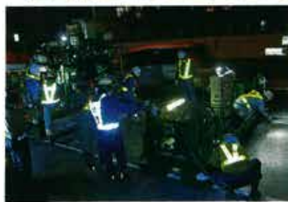
NIPPPO仕様の減速機、専用フィニッシャーが稼働する施工現場＝6月2日、首都高速7号小松川線
