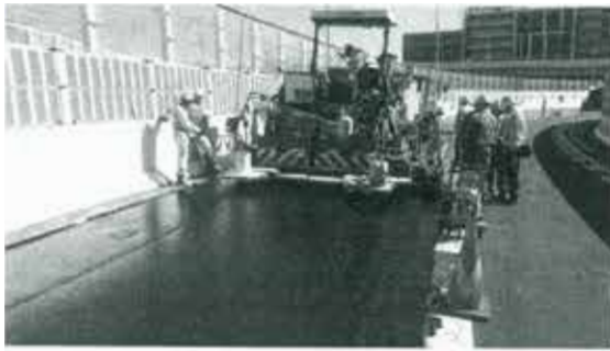
施工のようす
