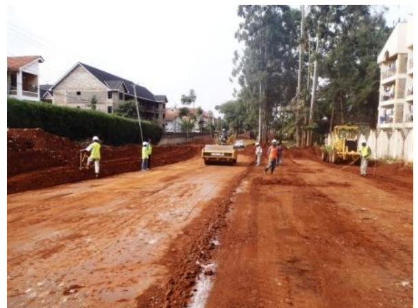
盛土工施工状況
