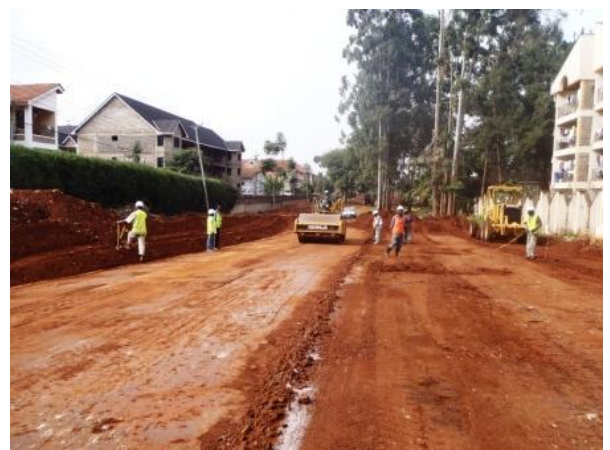
盛土工施工状況
