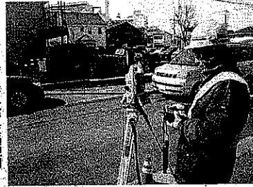
ノンプリズム方式で交通規制 する工区で現況測量
