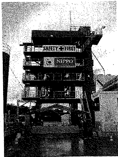
完成したプラント
