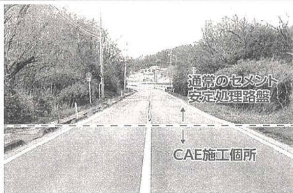
震災後の調査でCAE施工箇所（手前）に破損がないことを確認
