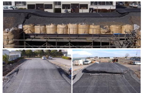
写真-1 複合剛性層の施工状況
