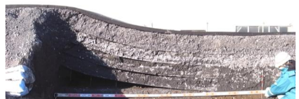
写真-4 複合剛性層による舗装の支持状況
