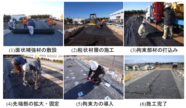
写真-1 複合剛性層の施工状況
