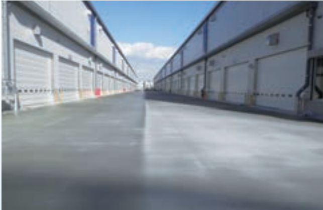
(仮称) 堺西物流センター新築工事 舗装工事
