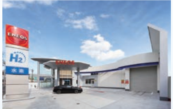
横浜綱島水素ステーション設置工事（設計・施工）
