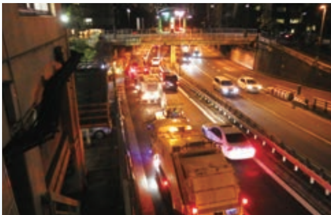
(修) 舗装改修工事1-201
