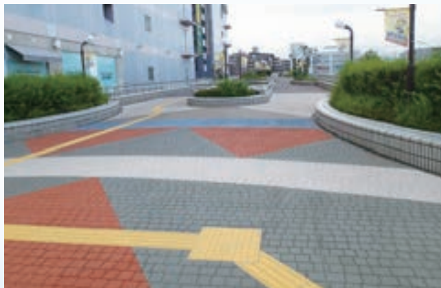
泉中央駅前ペDESTリアンデッキ改修工事6
