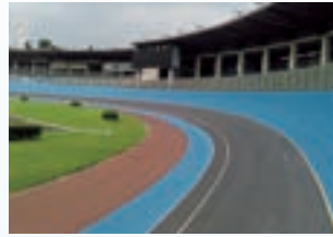
千葉競輪場競走路補修工事 (27-1)
