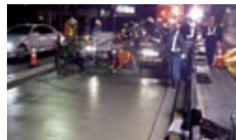
当工法は、施工・養生時間が短いため、交通規制が厳しい箇所にも多数採用中
