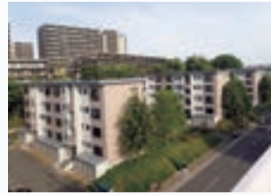
汐見台アパートリノベーション工事 (2303号棟～2305号棟)
