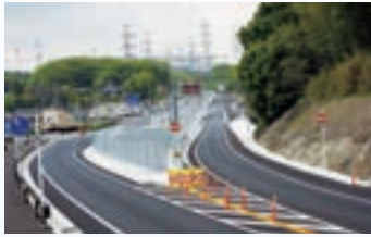
清滝生駒道路高山大橋舗装工事
