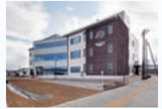
矢幅駅前地区整備等業務 (矢巾町活動交流センター「やはぱーく」)
