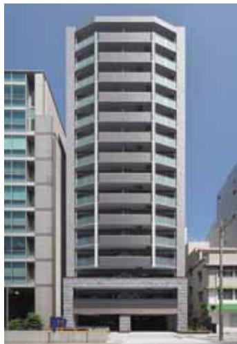
● 株式会社プレサンス コーポレーション (仮称)プレサンスロジエ 心斎橋新築工事 【大阪府】
