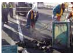
※従来のブレーカによるはつり (約90 ~ 100dB)
