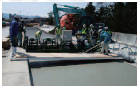
静岡県沼津市での国道の橋梁工事風景
