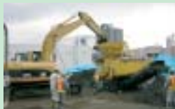
ホットソイル混合状況
