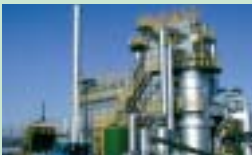
袖ヶ浦土壌浄化センター
