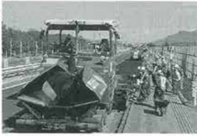
施工中のハイリジッドベース（上信越自動車道）
