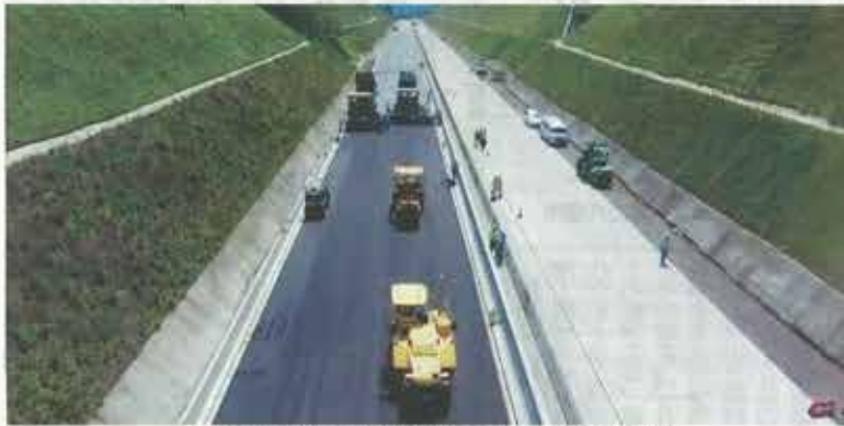
ICT技術の活用が進む新名神戸舗装工事現場
