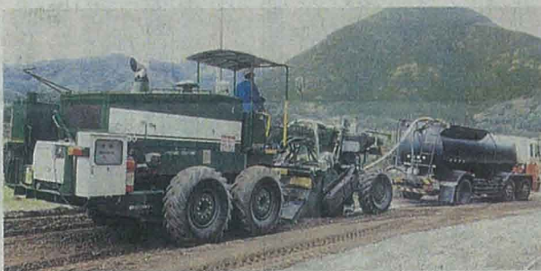
NIPPOがFRB工法で使用するロードスタビライザー
