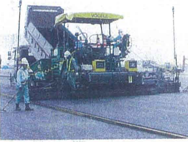
施工機械を自動制御し、高精度な仕上がりを実現
