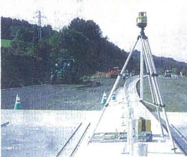
ゾーンレーザー発光器で高さ情報を正確に補正する
