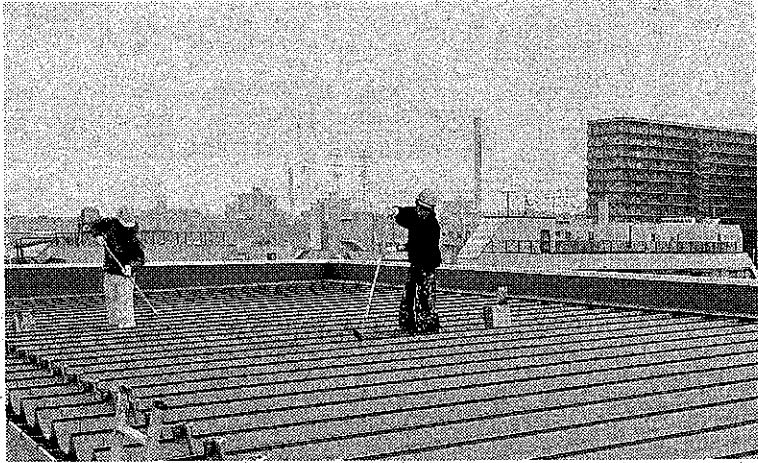
ミラクルの施工
