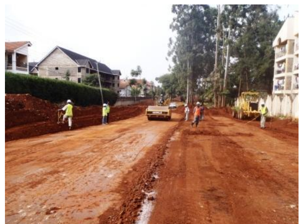
盛土工施工状況
