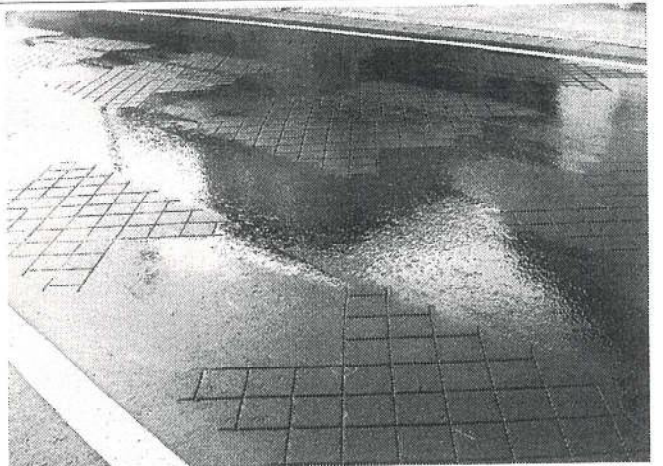
溝で排水し表面がウエットでも滑り抵抗性を確保
