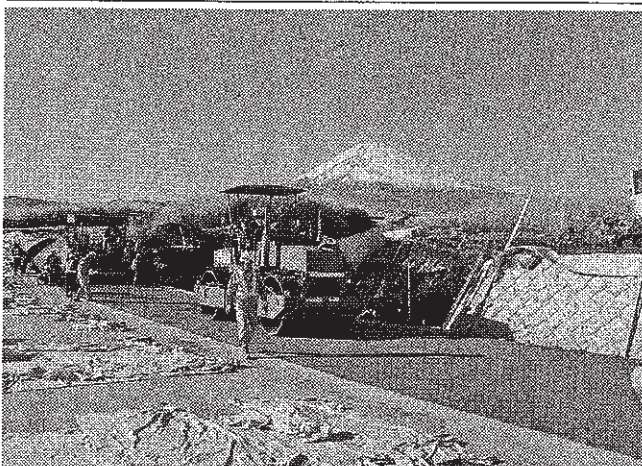
RCCPの施工状況（静岡県裾野市）
